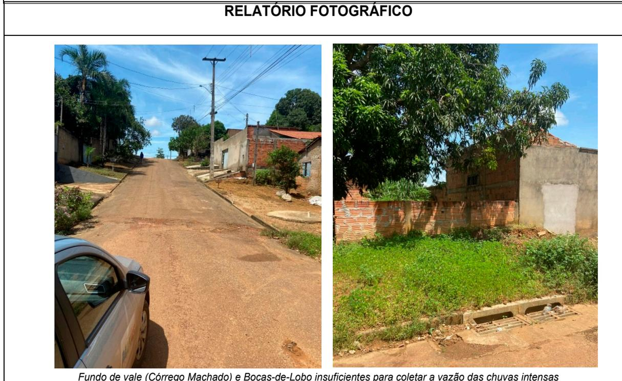
Fundo de vale (Córrego Machado) e Bocas-de-Lobo insuficientes para coletar a vazão das chuvas intensas
