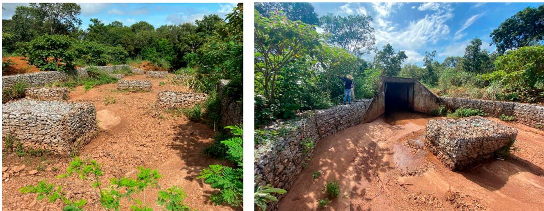
Blocos de dissipação de energia apresentam deformações e perda de volume (brita escapando pela malha).
