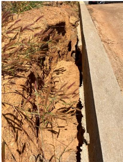
*Problemas de erosão do solo adjacente à estrutura do extravasor superficial*
