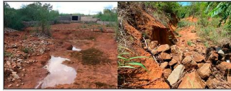
Figura 2-XXXIX: Processos erosivos por entalhamento do terreno, à jusante de estruturas de drenagem (Sussuapara)
