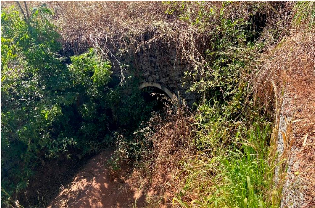
*Desemboque da rede de drenagem (3 tubos de 600mm), parcialmente obstruído*
