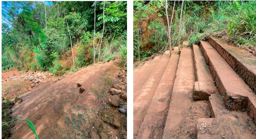
*Estrutura de dissipação de energia (escada hidráulica) em boas condições*
