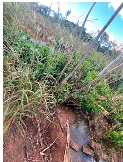
*Vista à jusante da descarga da rede, vegetação impede adequado escoamento*
