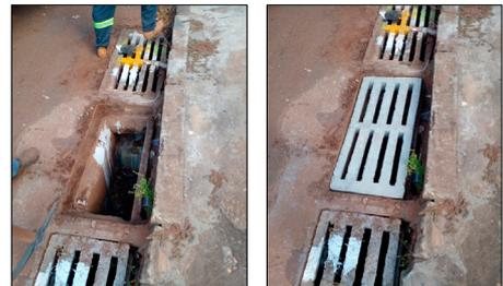
A posição das caixas das bocas de lobo, fora do calçamento, e na faixa direita de rodagem ocasiona frequentes rupturas pelo tráfego de automóveis.
