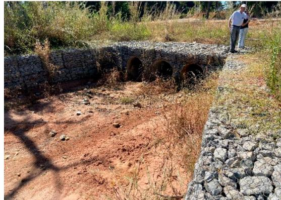
*Descarga da rede de drenagem em 3 tubos de 600mm*
