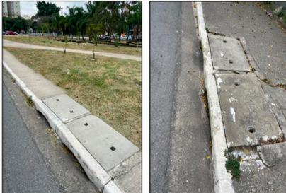
**Figura 3-XXVII: Bocas de lobo de Guia combinadas (2), com depressão, e caixa de inspeção na calçada - Corrego Zavuvus, São Paulo/SP**
