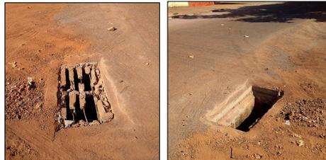
Boca de lobo mal posicionada, em intersecção de vias, fora da sarjeta/meio-fio: constante necessidade de substituição devido à ruptura grade pelo tráfego de automóveis.
