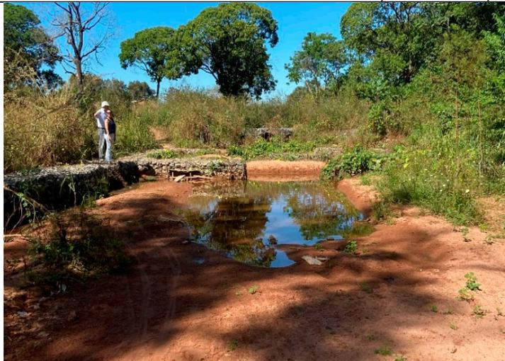
*Retenção de água devido à significativo acúmulo de "areia fina" ao longo da estrutura*
