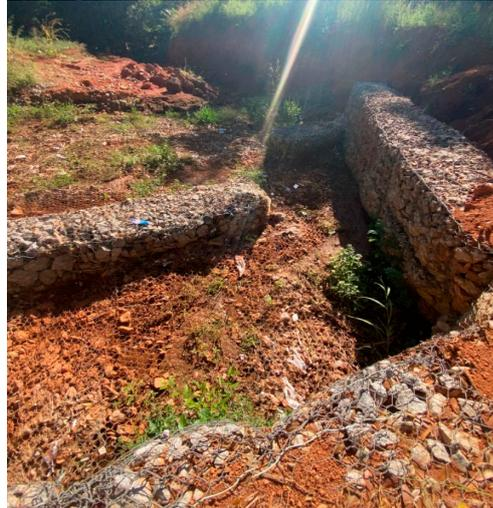
*Erosão e Ravinamento em torno da estrutura Estrutura íntegra, mas requer manutenção*
