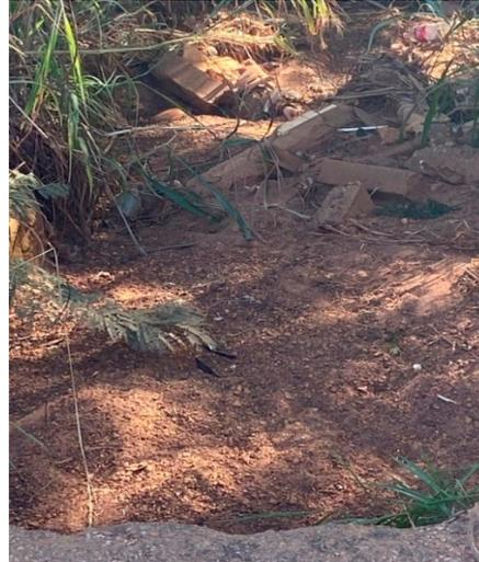
Vista à jusante – colapso do pavimento/calçamento – nota-se o carreamento dos blocos das guias
