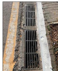
**Figura 3-XXIV: Tubulação de descarga na Boca de Lobo e Grelhas de ferro fundido, articuladas- São Paulo, SP**
