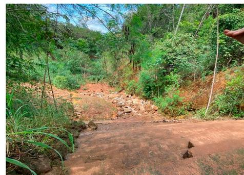
Altas vazões e velocidade de escoamento ocasionando carreamento de pedregulhos
