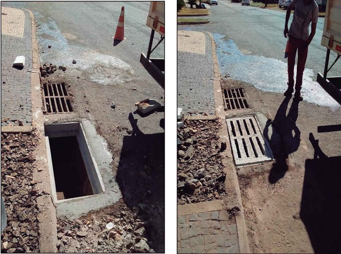
Desobstrução da caixa receptora da boca de lobo e substituição da grelha
