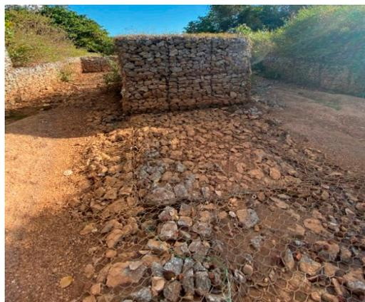
*Malha da estrutura conservada, com assoreamento -nas laterais- por diminuição de velocidade de escoamento*
