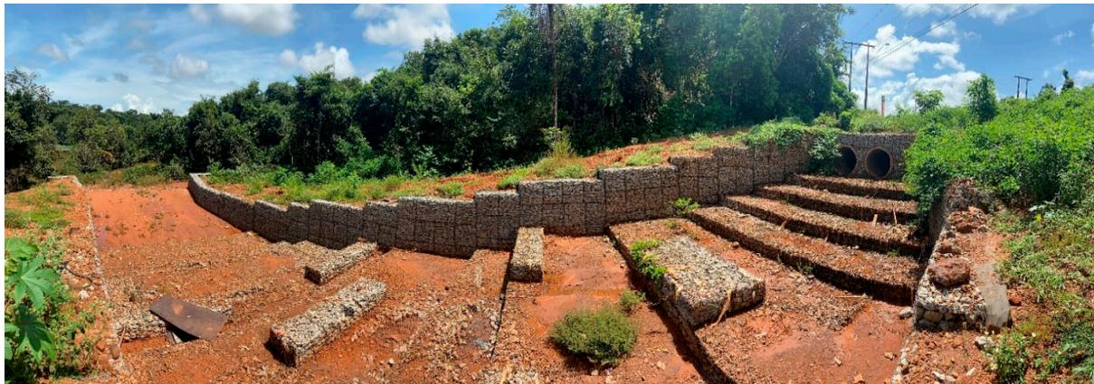
*Vista Panorâmica do Ponto de Lançamento – observa-se deposição de sedimentos, entulho, perda de material dos gabiões e vegetação a ser removida, para evitar obstruções.*
