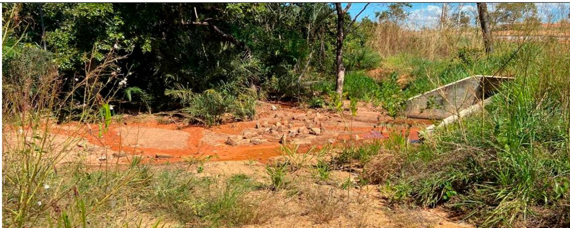
Vista geral do lançamento de rede – aparente tendência à carreamento de sólidos, dissipação de energia ineficaz
