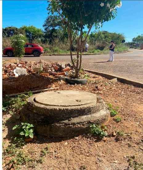
*Poço de inspeção da rede de drenagem*
