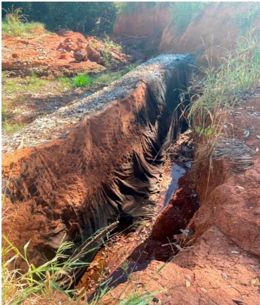
*Processo de forte erosão adjacente à ala do dispositivo*
