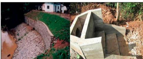
Figura 3-XX: Exemplos de proteção de margens e escada de dissipação
