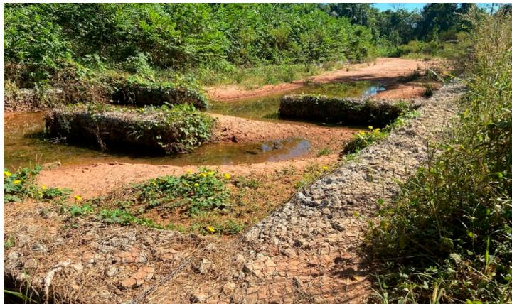
*Estrutura em gabões funcional – o visível assoreamento confirma redução de velocidade – e energia – do escoamento*
