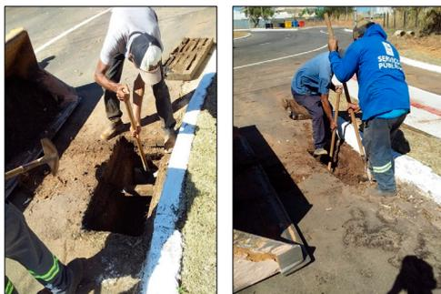
Desentupimento de Boca de Lobo e reparo de grelha em rotatória. Comente as grelhas de concreto localizadas em rotatórias da cidade são avariadas pelo tráfego dos automóveis
