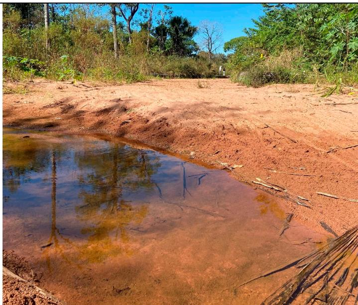
*Vista para montante da estrutura, onde a sedimentação “areia fina” resultante do assoreamento caracteriza a porção final do ponto de lançamento da rede de drenagem.*
