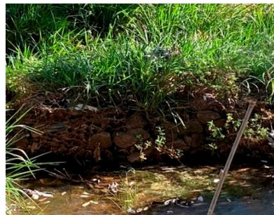
*Gabião infestado por vegetação – resultado da falta de limpeza e manutenção*
