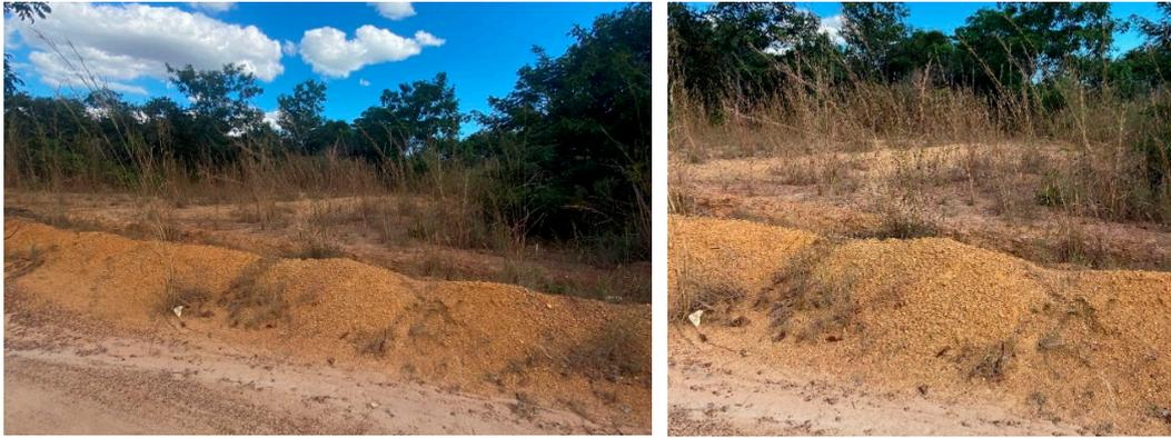
Acesso das águas à valeta ineficaz, obstruído pelo obstáculo de terra ao longo da via não pavimentada.
