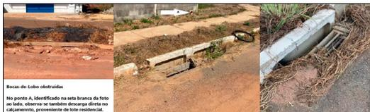
Figura 2-XLV: Exemplos de Bocas-de-Lobo obstruídas
