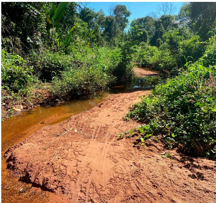
*Vista para jusante o ponto de lançamento, assoreamento ao longo de um canal à céu aberto que verte as águas pluviais*
