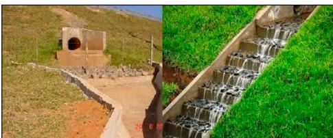
Figura 3-XIX: Exemplos de degraus e escadas de dissipação
