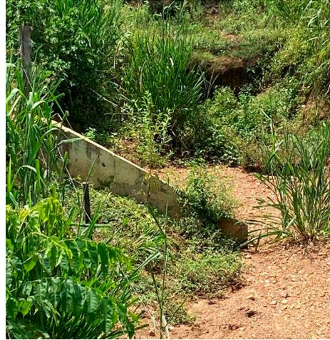
*Emboque da tubulação de drenagem, observa-se assoreamento.*
