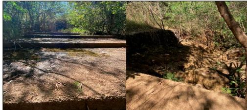
Condição em 2022: significativo adensamento da vegetação e carregamento completo do enrocamento que existia à jusante
