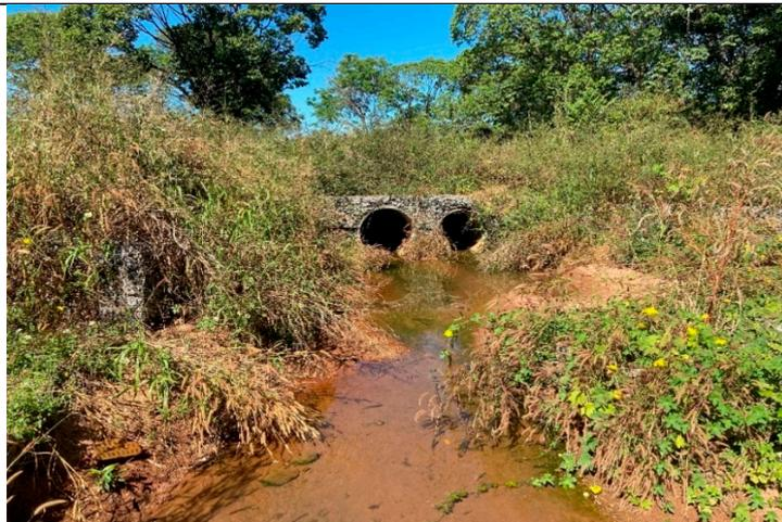
*Descarga em 2 tubos de 600mm - assoreamento e infestação vegetal – necessário limpeza e manutenção*
