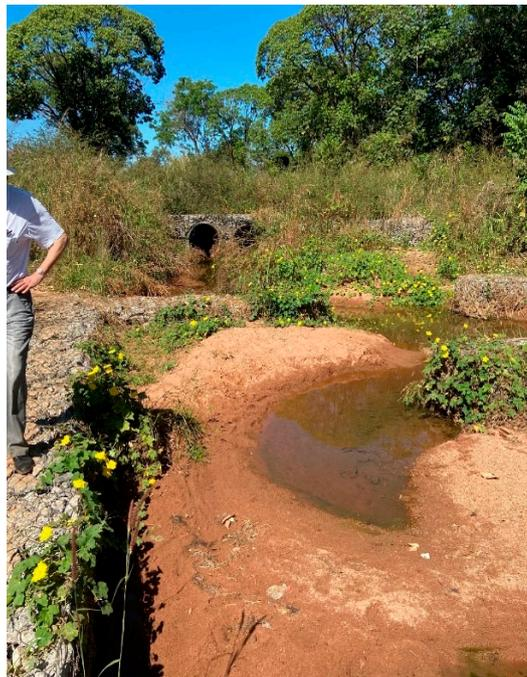
*Intenso acúmulo sedimentar devido à assoreamento na estrutura - efeito é esperado, mas requer dragagem e limpeza*
