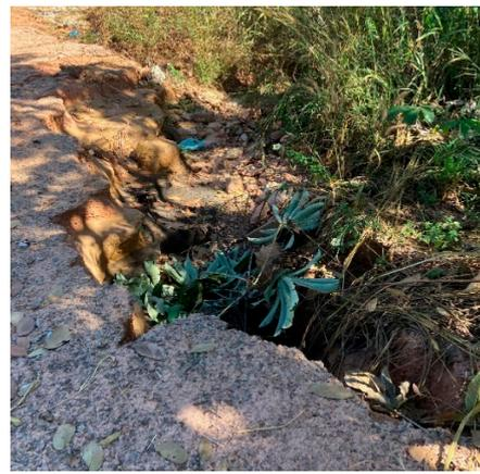
*Pavimento colapsado na aproximação do local onde a rede de drenagem desemboca – não há guias nem calçamento*
