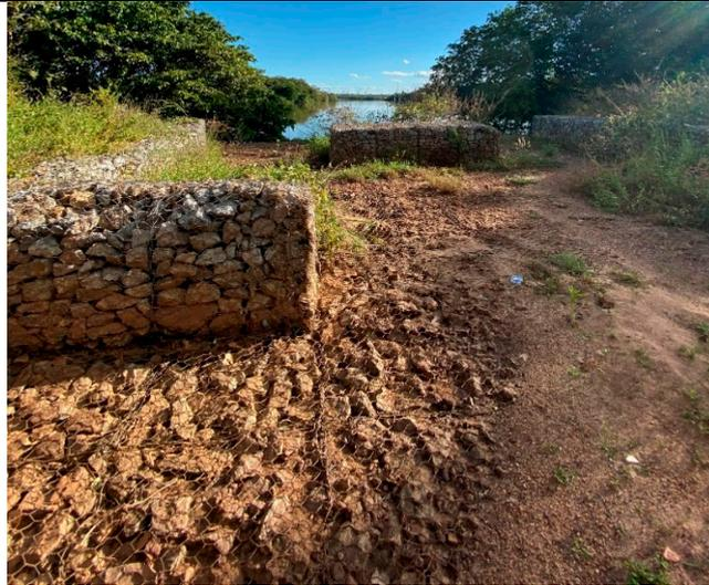
Observa-se assoreamento pela diminuição da velocidade de escoamento no desague direto no Ribeirão Taquaruçu
