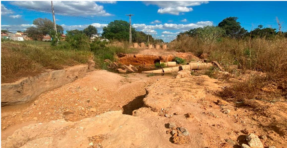
*Erosão na via pública com tubulação colapsada*
