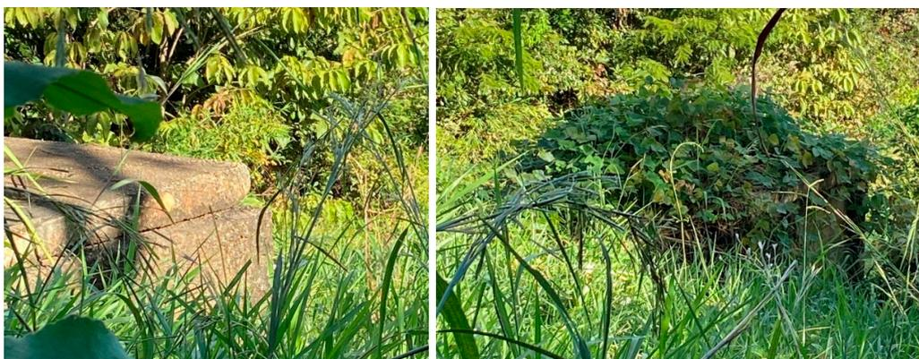
*Caixas de passagem e inspeção infestadas por vegetação - localizadas antes da descarga da rede, que não está acessível*
