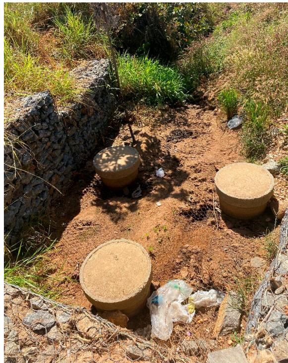
*O extravasor tem alta declividade e queda de 1,5 m sobre a descarga da rede, em gabiões.*
