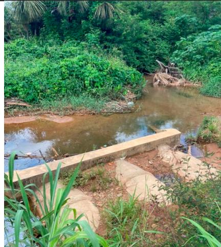
*Emboque dos tubos de drenagem, observa-se assoreamento e manutenção (limpeza e dragagem) precária.*
