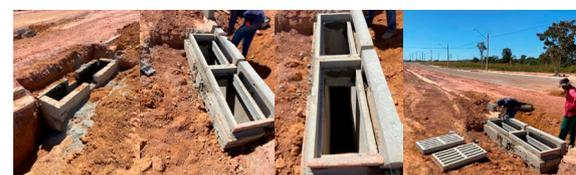
Figura A-IV-9: Obras no setor Morada do Sol - bocas de lobo e pavimentação.
