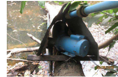
Captação de água sem autorização.
