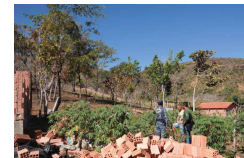
Loteamentos irregulares na zona rural, ocupação de APP e consequentemente captação irregular de água.
