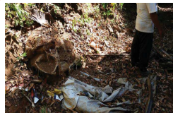
Barragem de sacos de cimento, sem autorização e ciência do órgão competente.
