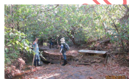
Barragem de alvenaria no córrego Água Fria sem autorização.
