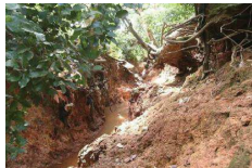
Trecho de afluentes do Córrego Tiúba em estágio avançado de erosão.
