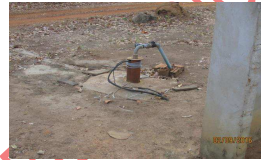
Poço aberto sem autorização.
