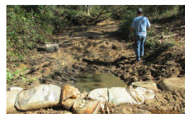
Barramento sem autorização no córrego Água Fria.
