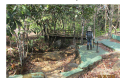
Construção irregular no córrego Água Fria.
