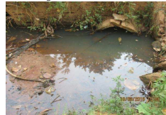
Assoreamento no Córrego.
